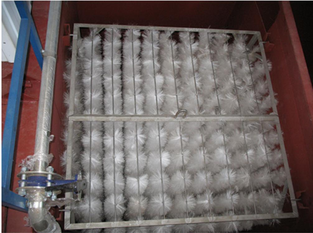
**Ершовая загрузка – элемент установки биологической очистки воды, где обитают полезные бактерии**
