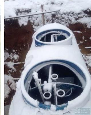
*«Доступность» технологических элементов и технологических носителей через горловины емкостей*
